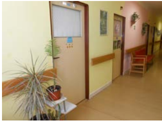
Budova D - chodba
